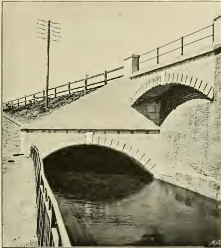
Abb. 136. Durchlass aus Stampfbeton auf dem Brünner Nordbahnhofe.
